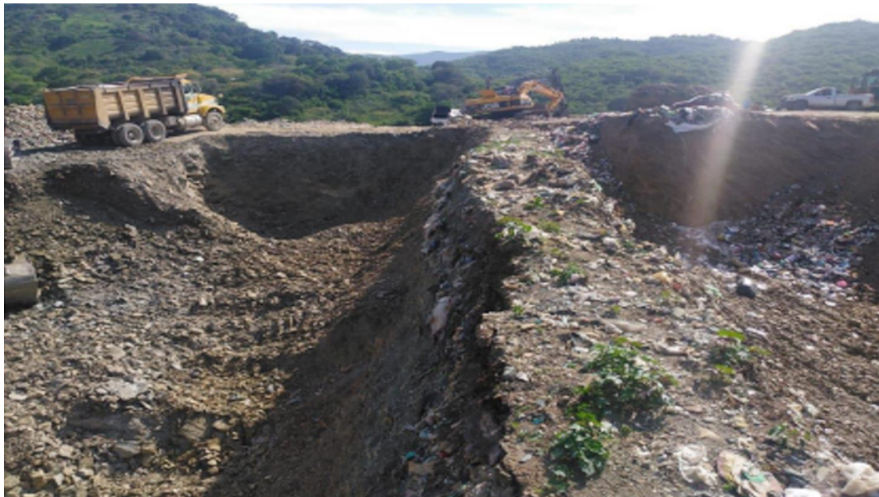
Figura 3. Celdas elaboradas para la separación y compactación de RSU
