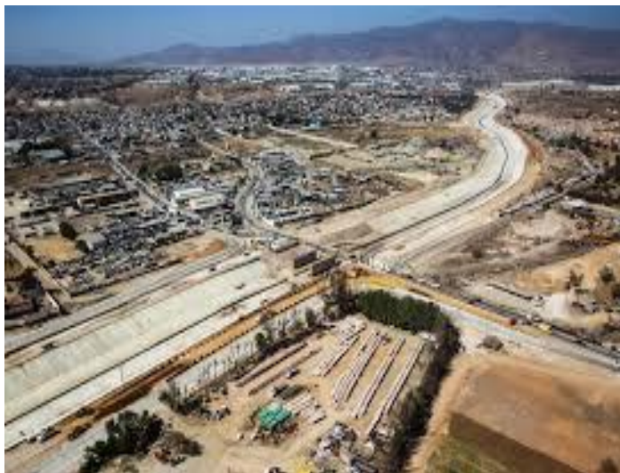
Figura 4: Canalización del arroyo Alamar.
